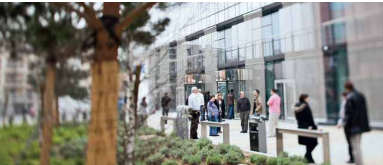
Bâtiment à haute efficacité énergétique à Suresnes. France.
