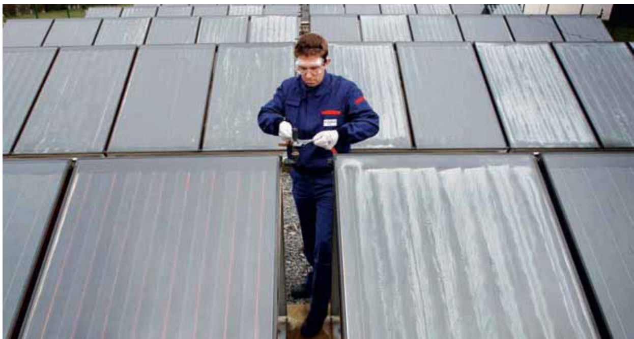
Installation de panneaux solaires. France.
