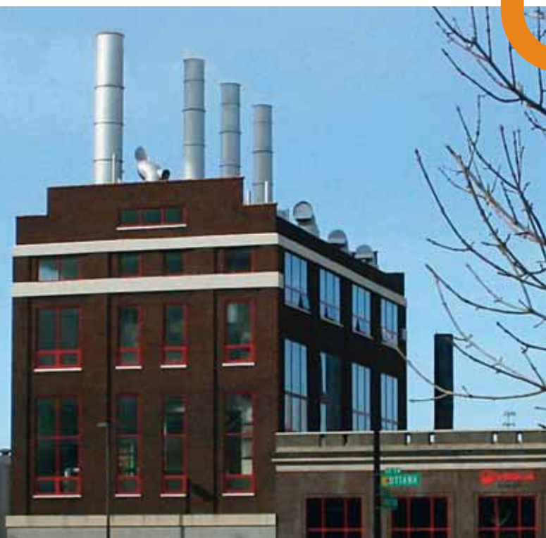
Chaudière centrale de Grand Rapids. États-Unis.
