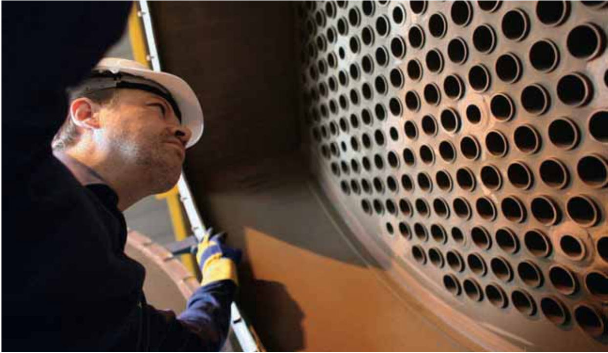
Installation de l'hôpital de Southampton. Royaume-Uni.
