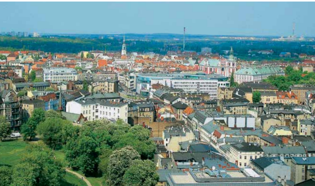
Exploitation du réseau de chaleur de Poznan. Pologne.
