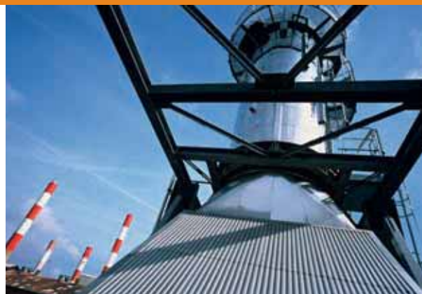
Cogénération d'un site industriel à Tavaux. France.
